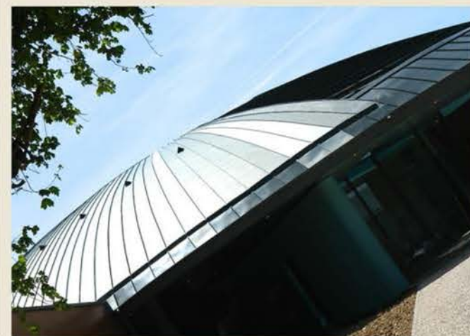
Maisons bois et Détails sur toiture Zinc
